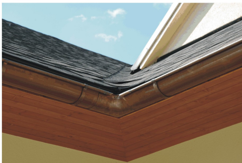
Detail překrytí šindelů v úžlabí střechy
