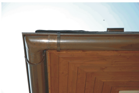
Detail napojení měděných žlabů
