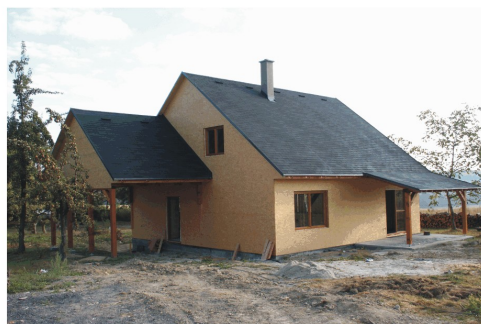
Realizace střechy v Hutisku Solanci (IKO Black)
