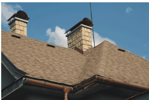
Realizace střechy v Kopřivnici (šindel IKO Cambrige)
